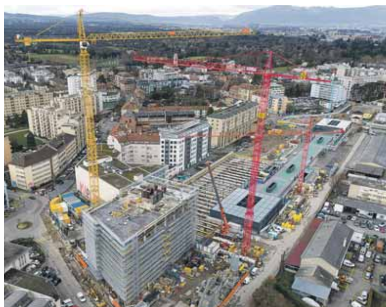
Vue des chantiers du périmètre de la future halte du Léman Express.
