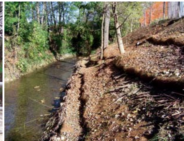
Travaux de consolidation des berges à Ville-la-Grand, utilisant des techniques de génie végétal*.
