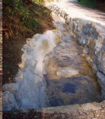
Stabilisation du torrent de Chez Fournier.
