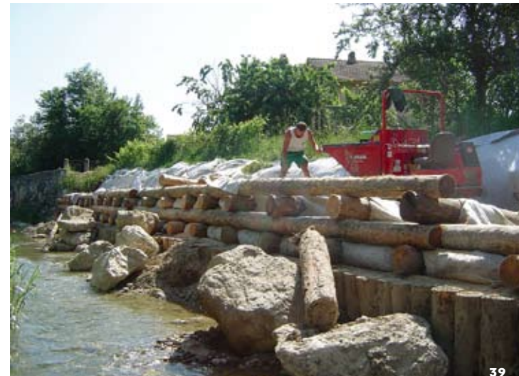
Travaux de renforcement des berges contre l'érosion à Gaillard.
